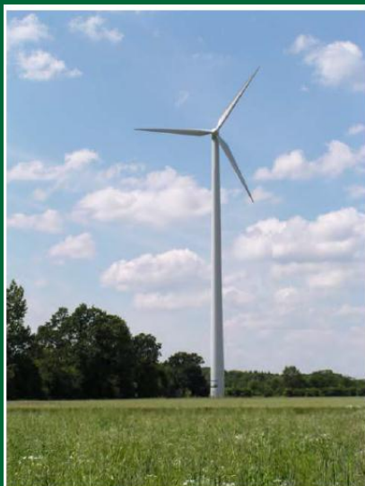
VESTAS V47 200 kW h=65 m, r=24 m rpm=[20 26]
