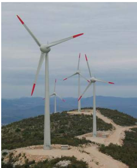
Razrita in zabetonirana pokrajina po postavitvi vetrnic.
